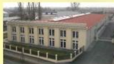
Dresdener Straße 66 – Zerspanung
