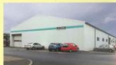
Dresdener Straße 68 – Zerspanung
